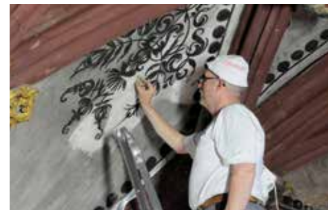
Trockenreinigung der Gewölbekappen mit Akapad-Schwämmen
