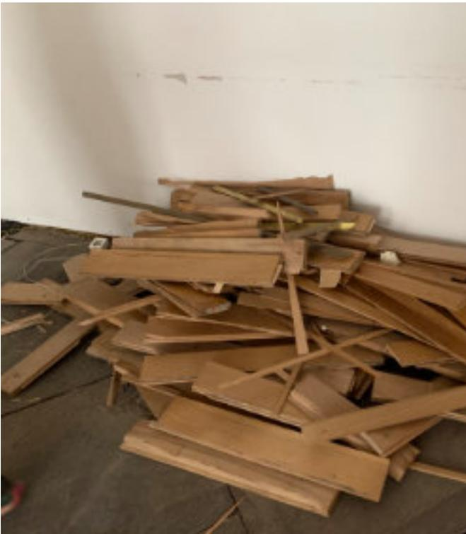
Der neuzeitliche Riemenboden ist demontiert. Darunter der originale «Berner Boden».
